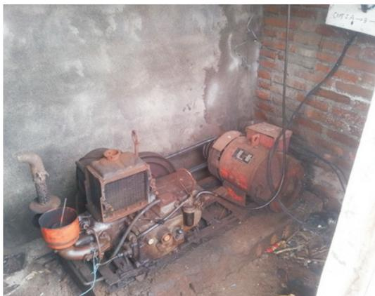
Satu generator dengan kapasitas sekitar 1 KVA sangat penting untuk cadangan suplai listrik, dikarenakan jika suplai listrik utama mengalami gangguan (listrik PLN padam) dapat menyebabkan sistem aerasi mati sehingga berpotensi untuk kegagalan panen benih ikan kerapu.
