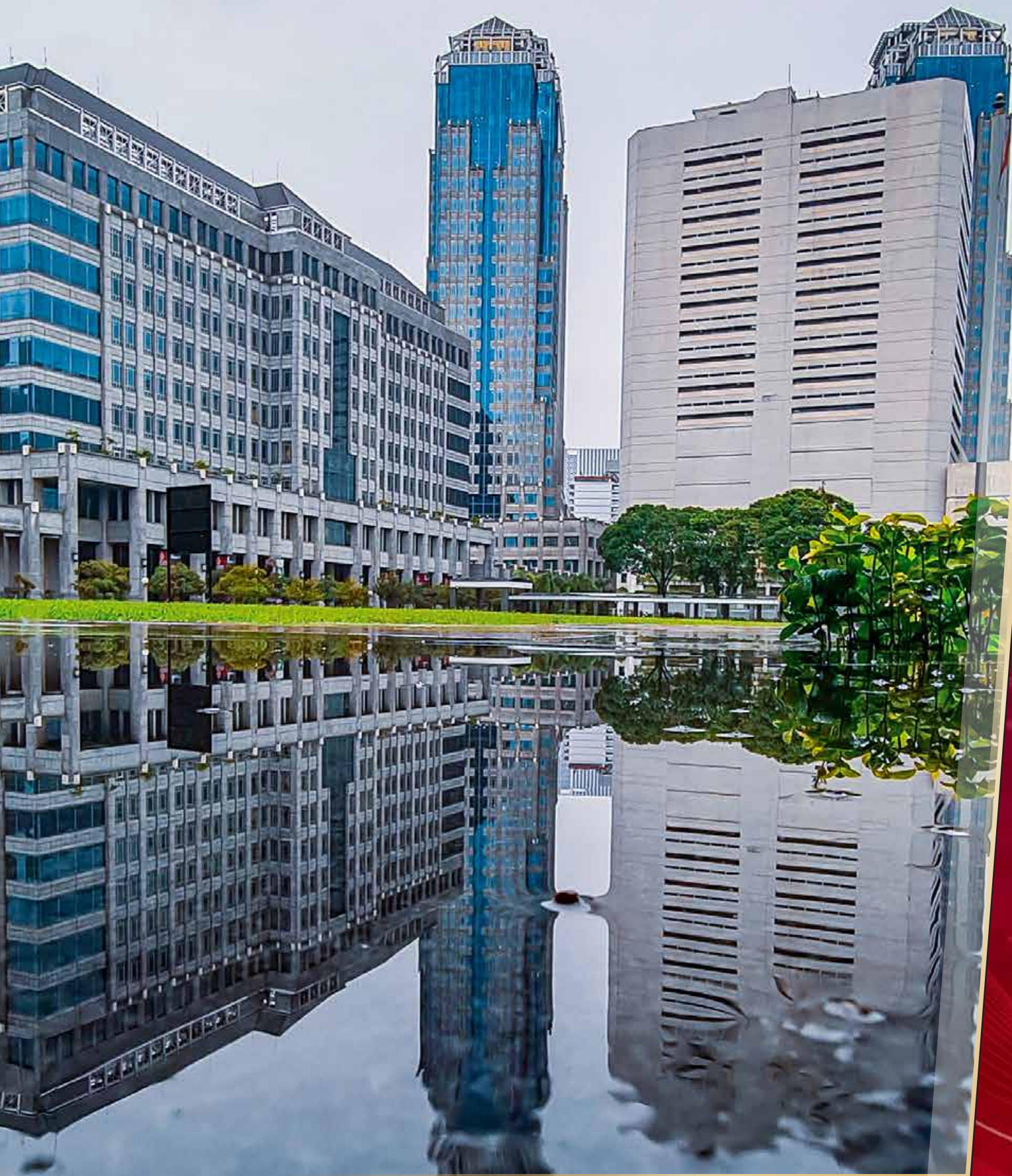
Komplek Perkantoran Bank Indonesia (Koperbi) Jakarta
