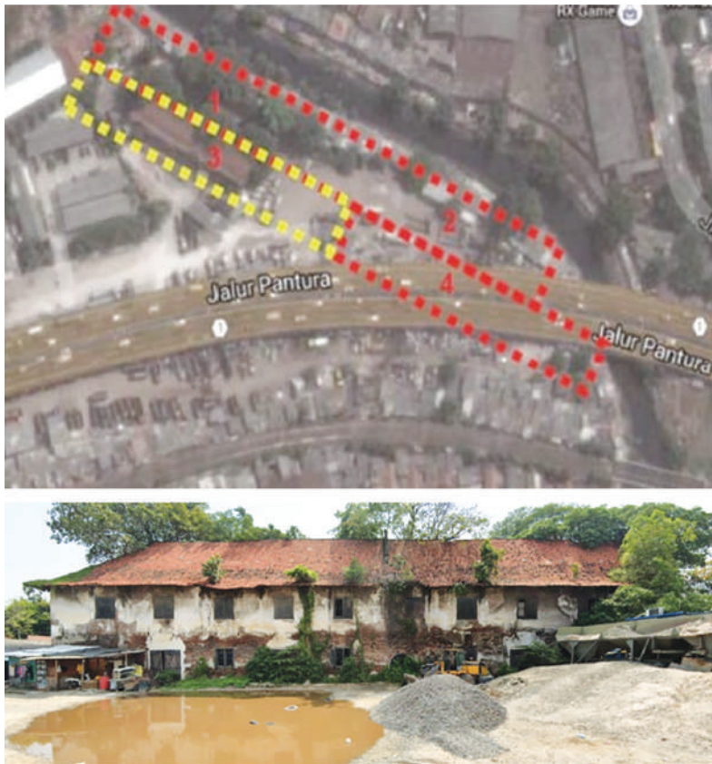
Gambar 5.24 Gudang Timur yang Masih Tersisa Sumber: Pusat Dokumentasi Arsitektur
