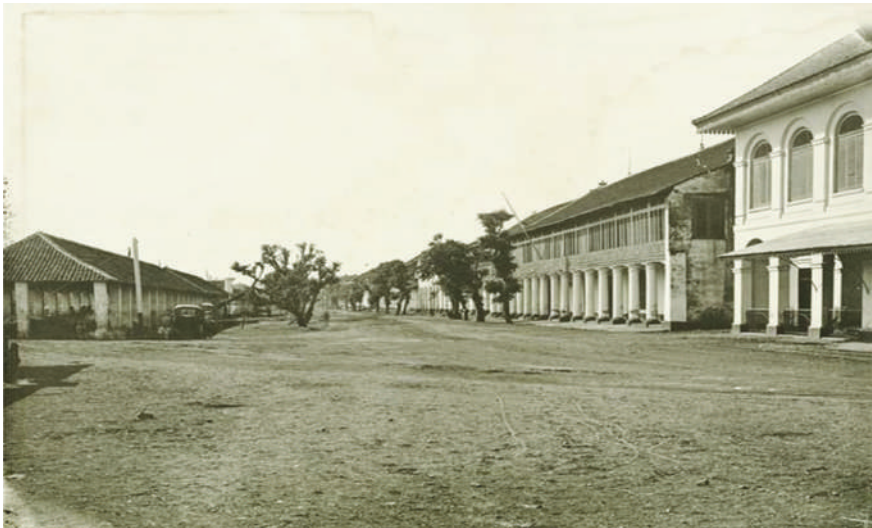
Gambar 7.6 Perkantoran dan Pergudangan di Kali Besar Barat Sumber: Firma Maclaïne, Watson & Co, Woodbury & Page (Batavia). KITLV 82560
