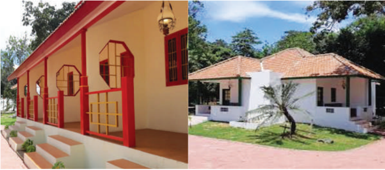
Gambar 3.15 Bangunan Tematis Batavia Tempo Doe/oe di Pulau Bidadari
